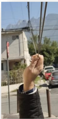
Foto 8: A menos de 1.80 meros y obstruyendo cochera.
