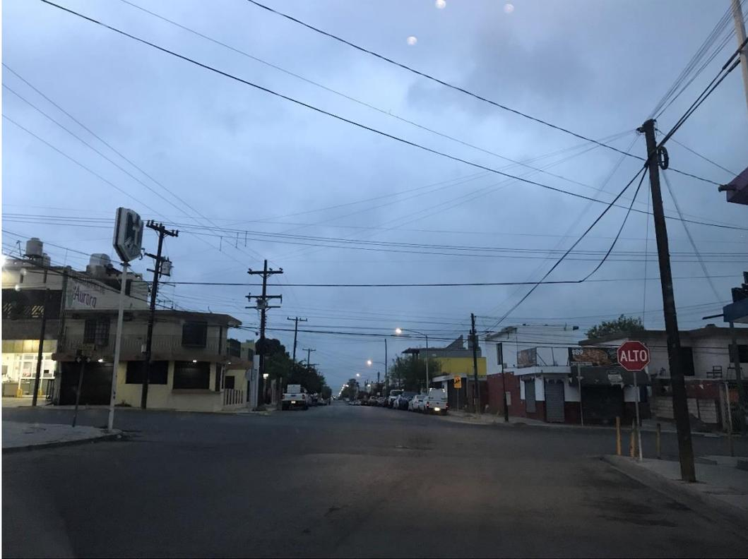
**Imagen A. Intersección Cóndor-Pelícano, vista desde Calle Cóndor. No hay cebras peatonales, escasos letreros de ordenamiento vial, poca iluminación, no hay rampas para discapacitados, parada de autobuses no señalizada. Zona caótica de tránsito vehicular y de difícil paso para peatones.**
