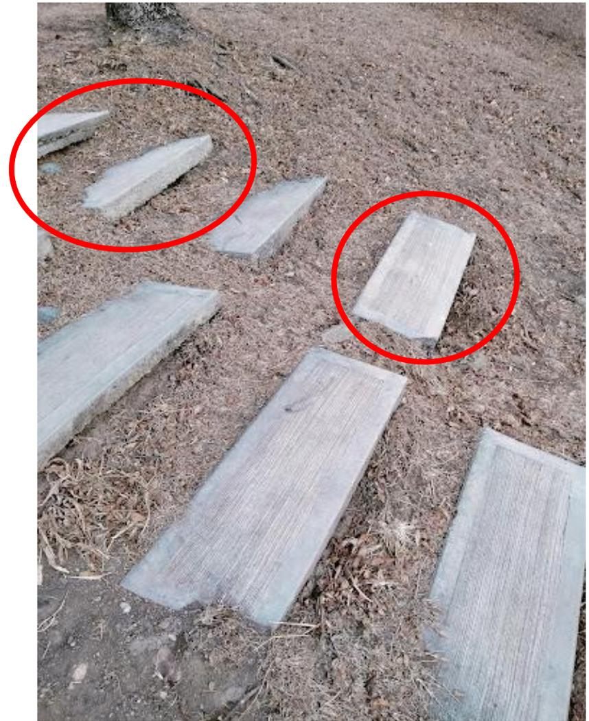
Estas fotografías muestran las condiciones del andador, el cual tiene las losas muy separadas, desniveladas, faltan algunas y algunas inclinadas hacia abajo, con el peligro de resbalarse
