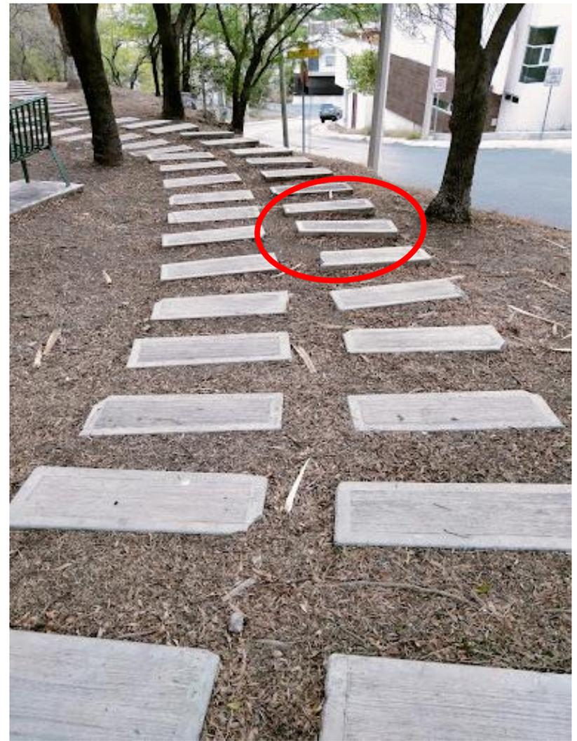
El andador tiene las losas de escalón todas muy separadas y en su mayoría desniveladas, lo cual hace muy difícil caminar sobre ellas y con el peligro de una torcedura de pie. Además, la separación entre los escalones y la inclinación negativa de cada uno es muy fácil de resbalarse, ya que al ser una escalera debería contar con pasamanos, algo de lo que adolece
