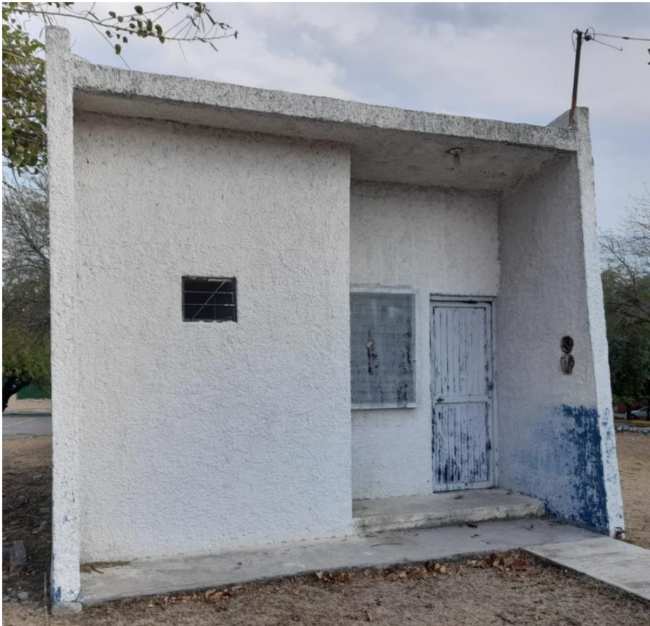
4).- Caseta de Vigilancia Inactiva - Villa Las Fuentes 2º Sector (En Parque Villa Las Fuentes 2º Sector)
