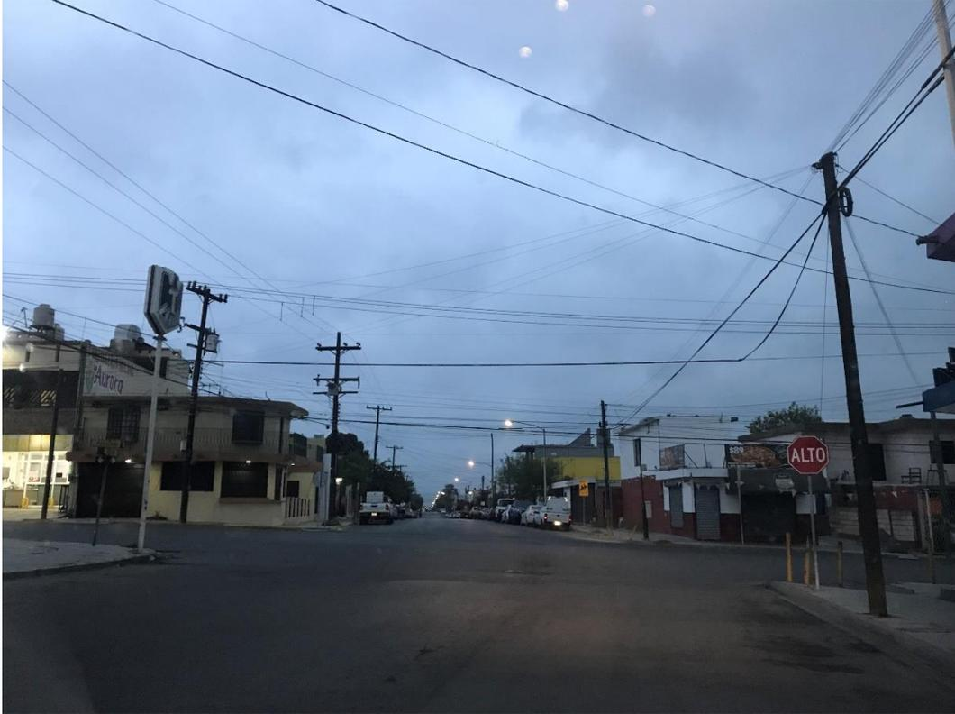
Imagen A. Intersección Cóndor-Pelicano, vista desde Calle Cóndor. No hay cebras peatonales, escasos letreros de ordenamiento vial, poca iluminación, no hay rampas para discapacitados, parada de autobuses no señalizada. Zona caótica de tránsito vehicular y de difícil paso para peatones.
